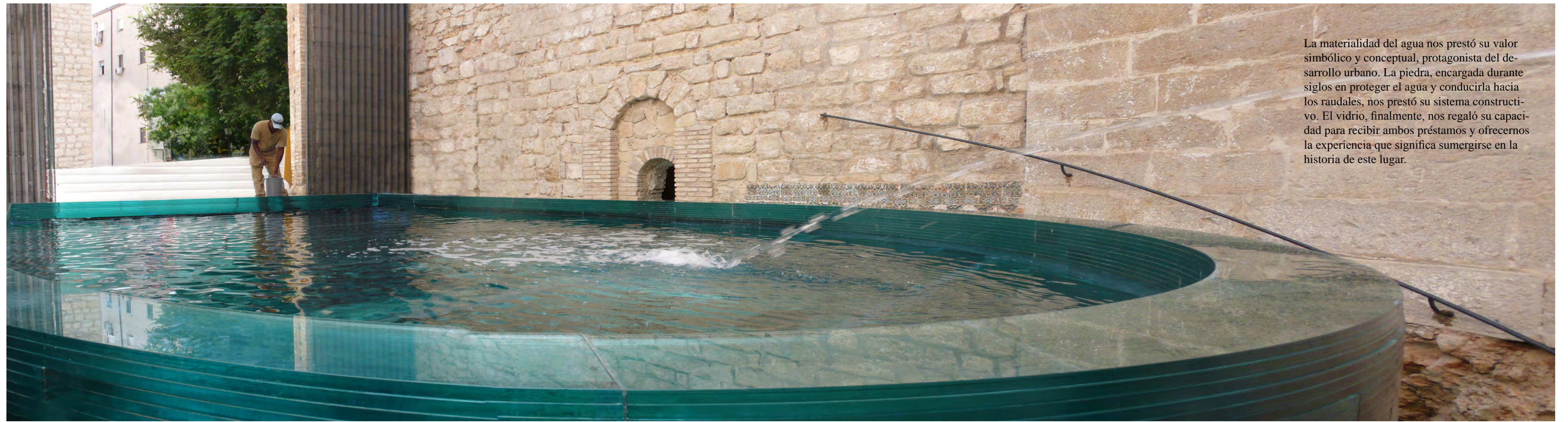
La fuente está construida con muros de carga de vidrio azul de 19 mm. apilados y fijados mediante resinas transparentes. El espesor total es de 25cm.
