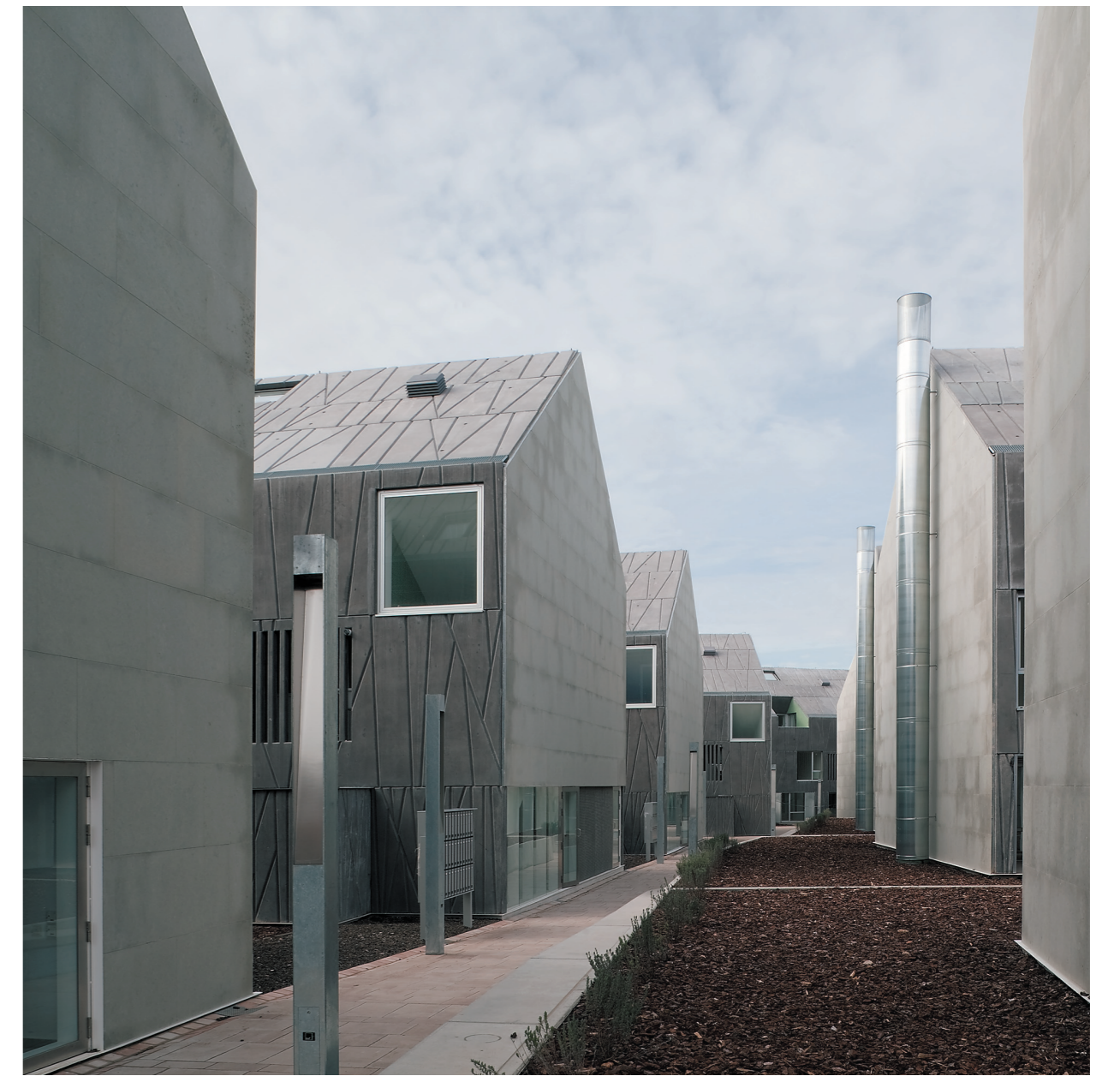
Vista de la calle interior
