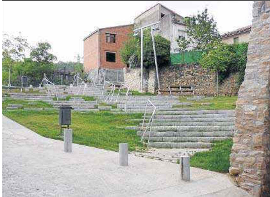
Vista actual de la remodelada plaza Mosèn Tàpies de Oliana, una de las tres de esta localidad premiadas.
