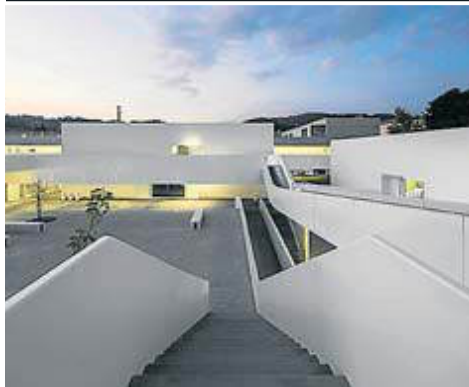
—02— L'escola a Sever du Vouga, de Pedro Domingos, és l'altre edifici reconegut amb el premi FAD. FERNANDO GUERRA
