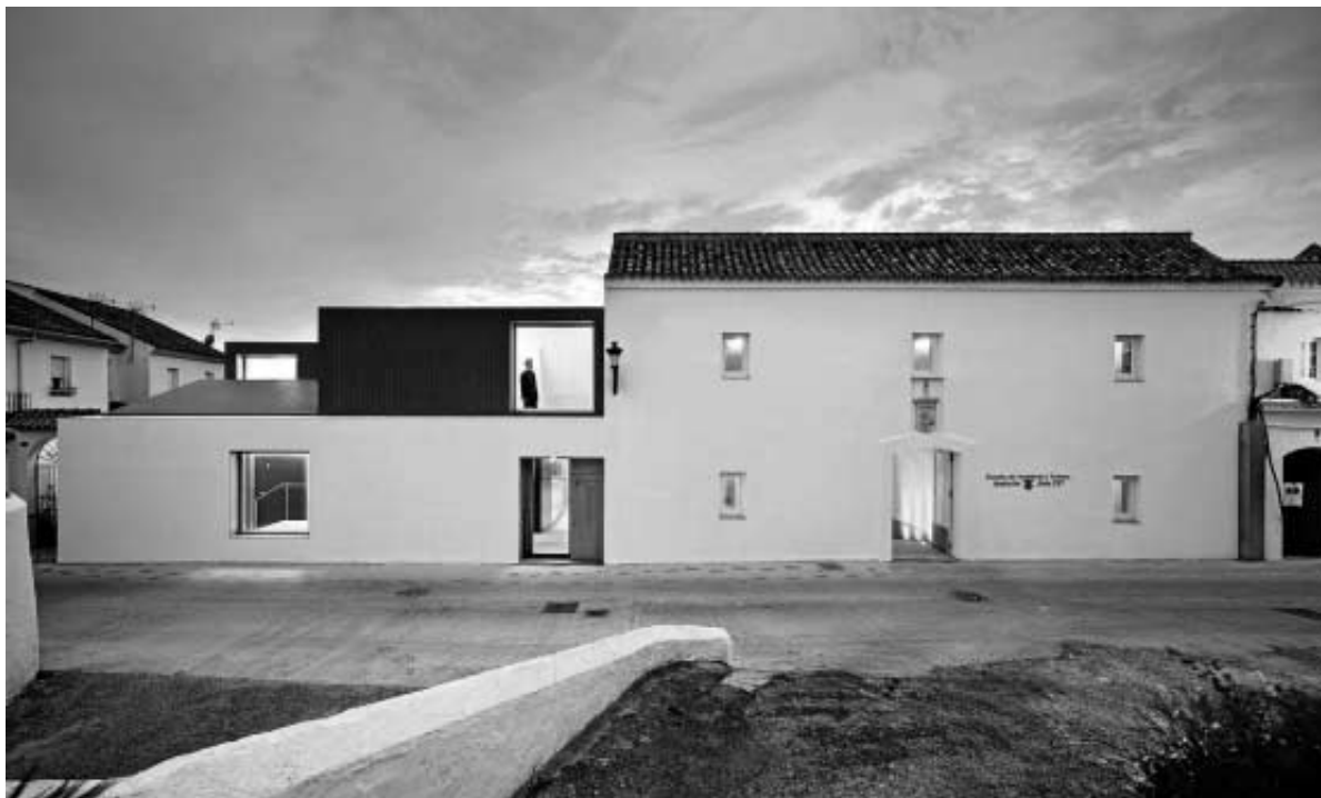
Fachada principal de la Escuela de Hostelería de Medina, donde se ubicaba el antiguo matadero.
