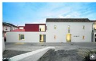
Fachada principal de la Escuela de Hostelería de Medina, donde se ubicaba el antiguo matadero.
