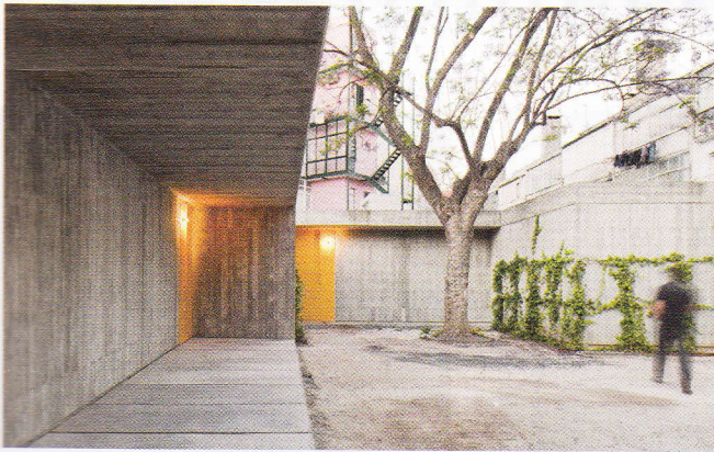
2 Casas em Santa Isabel, premi Fad exaequo d'Arquitectura 2011. Rua Saraiva de Carvalho, 42. Lisboa. Autor: Ricardo Bak Gordon, arquitecte
