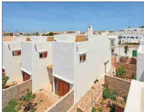
'Life Reusing Posidonia', del equipo de arquitectos del IBAVI, se encuentra en la localidad de Sant Ferran, en Formentera.
