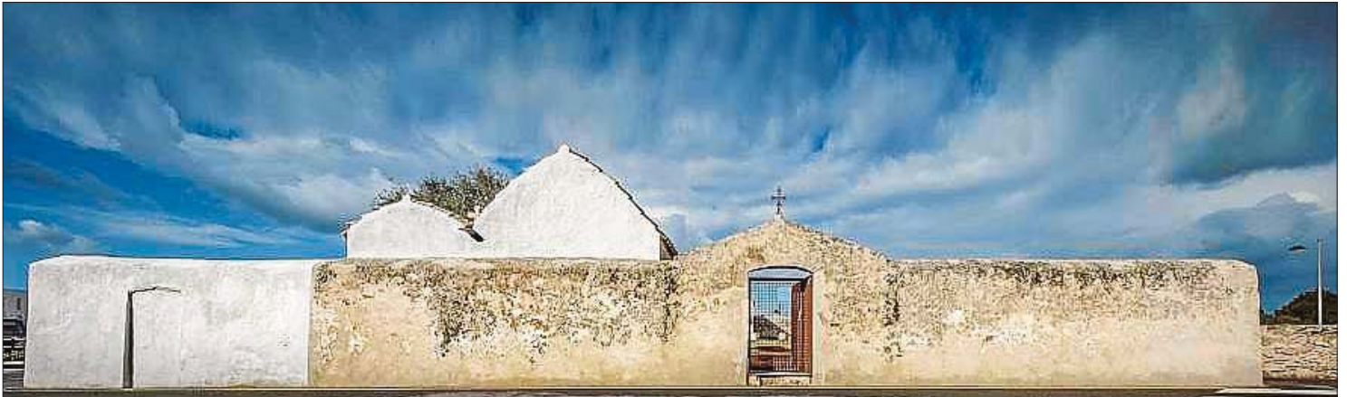
Fachada restaurada del cementerio viejo de Sant Francesc Xavier. M. CASTELLÓ
