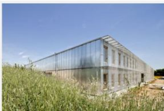
Fotógrafo: Adrià Goula / Harquitectes+dataAE
