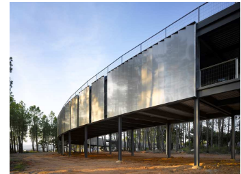
CENTRO DE TECNIFICACIÓN Fotógrafos: ROLAND HALBE, PABLO CALZADO, CONSEJERÍA DE LOS JÓVENES Y DEL DEPORTE (JUNTA DE EXTREMADURA) Mención 2010
