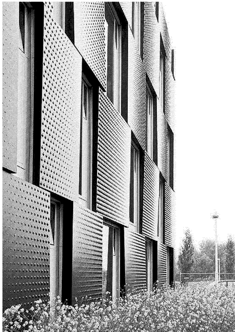
Centro deportivo en Utrecht, obra de Wiel Arets.
