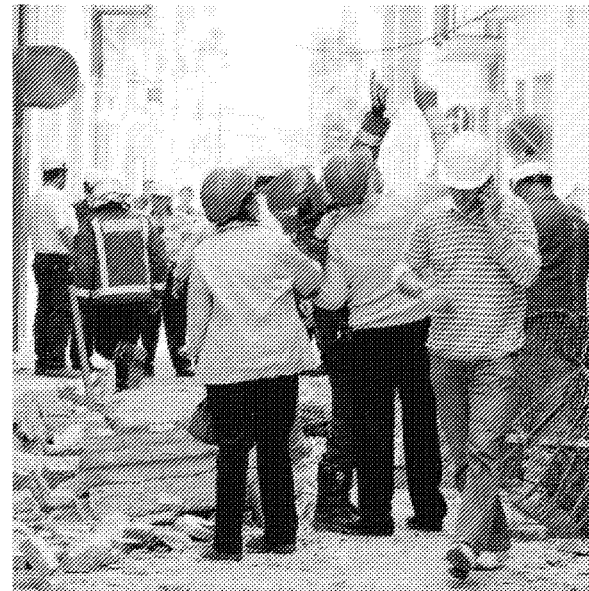
Los técnicos observan la calle de Figueras donde murió un obrero en marzo
