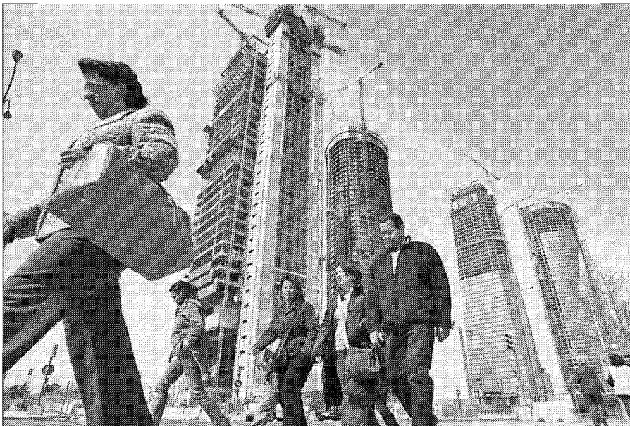
Ciudadanos transitan junto a las torres que se construyen en los terrenos de la antigua Ciudad Deportiva del Real Madrid. / G. L.
