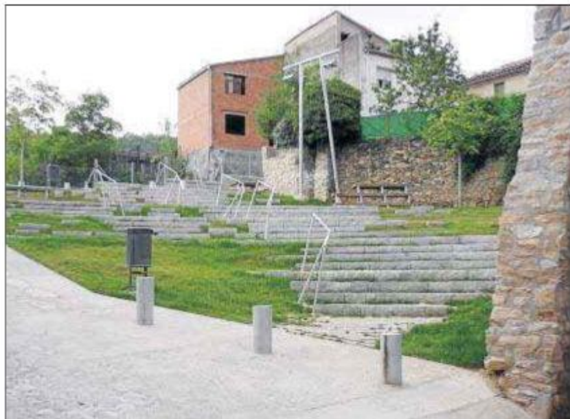
Vista actual de la remodelada plaza Mossèn Tàpies de Oliana, una de las tres de esta localidad premiadas.
