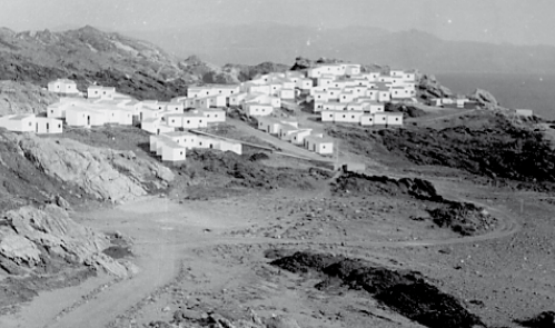
1961. Construcció del Club Med. Font: COAC Girona
