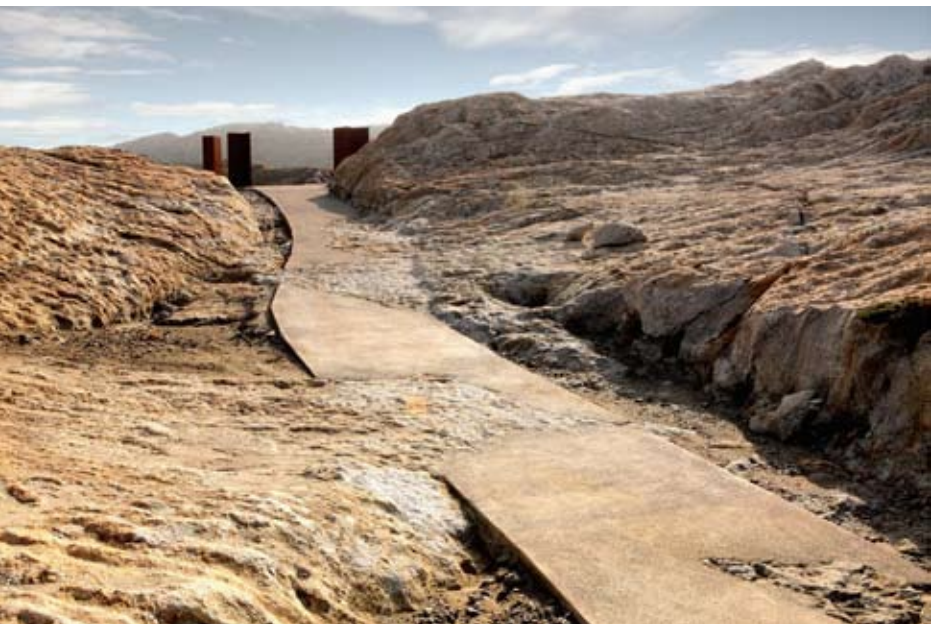
Pas de la 'Pegmatita', major aflorament del massís. Es retira i rebaixa el nivell de la vialitat original d'empedrat, per mostrar aflorament.
