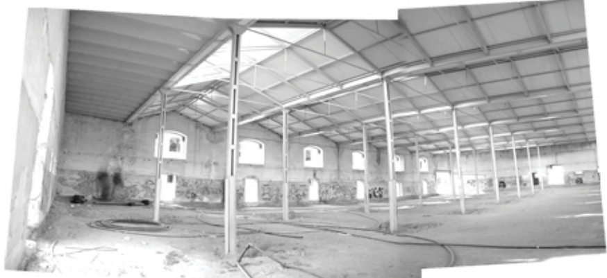
ESTADO ORIGINAL DE LA NAVE
