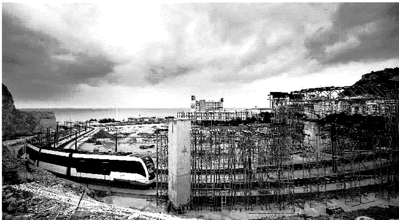
EN OBRAS. Paso del tranvía por el tramo de la línea 1 que atraviesa Sangueta junto a la Cantera y el nuevo ramal para la línea 2. / CARLOS RODRIGUEZ
